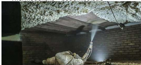
Eco schuim-Jetspray (betonnen vloer)
